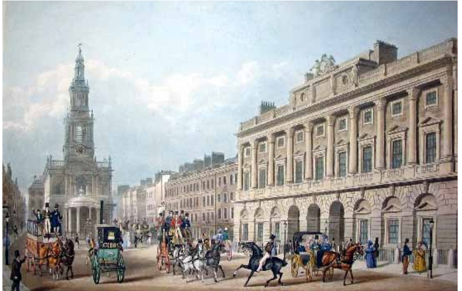
Somerset House in 1836 Wikimedia Commons (CCL)
